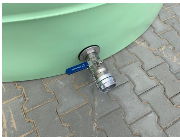
Rys. 13. Zawór kulowy dolnego poboru ze złączem typu STORZ - widok zaworu w pozycji zamkniętej
